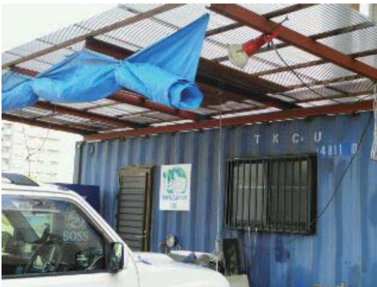
増設後のちからこぶジム。最初はガレージに屋根がなかった。
